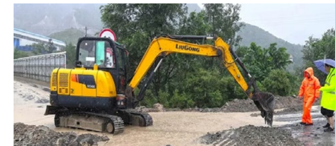
养护人员正在疏通并改变桥面水流方向
